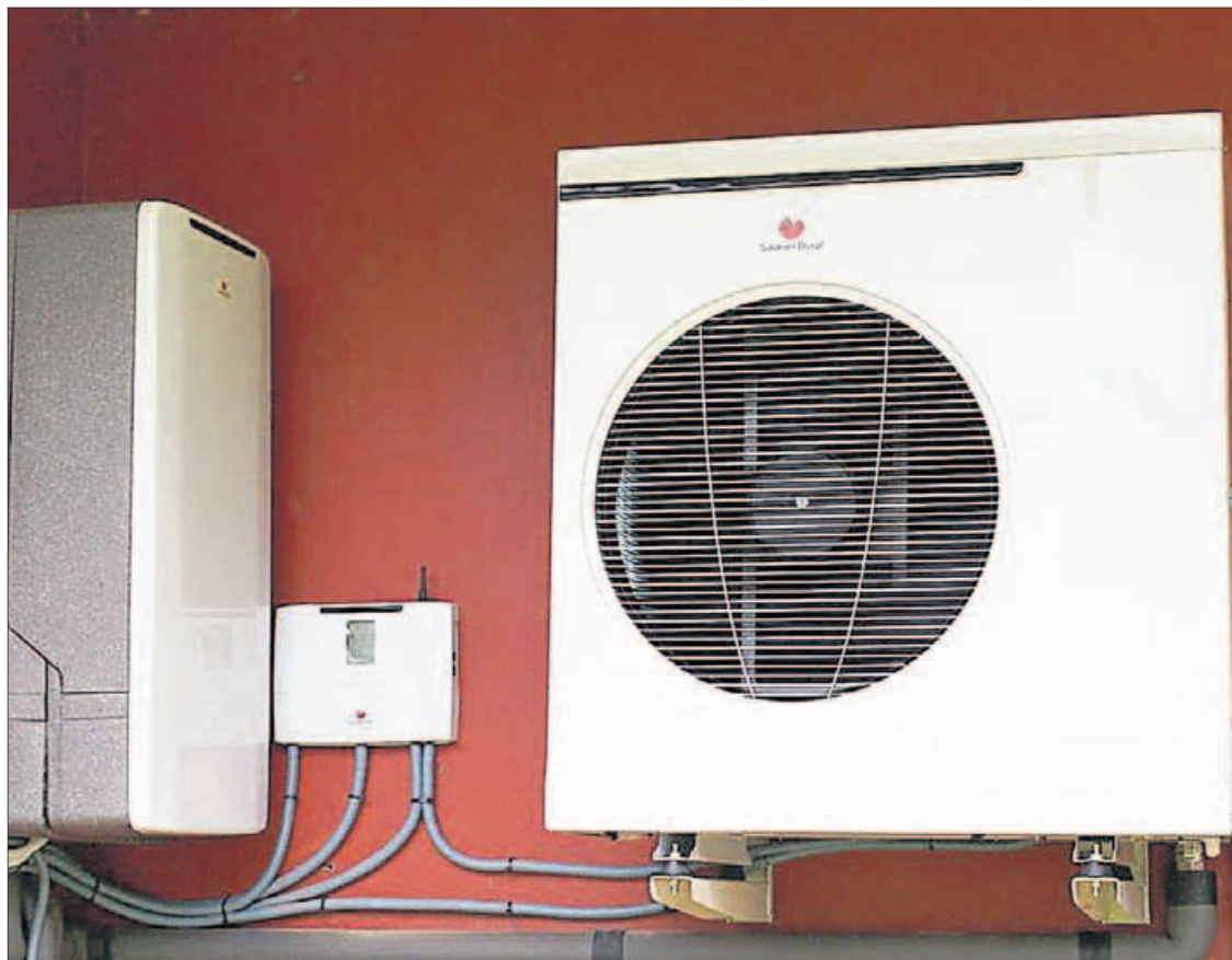
Componentes de un sistema híbrido en una vivienda.
