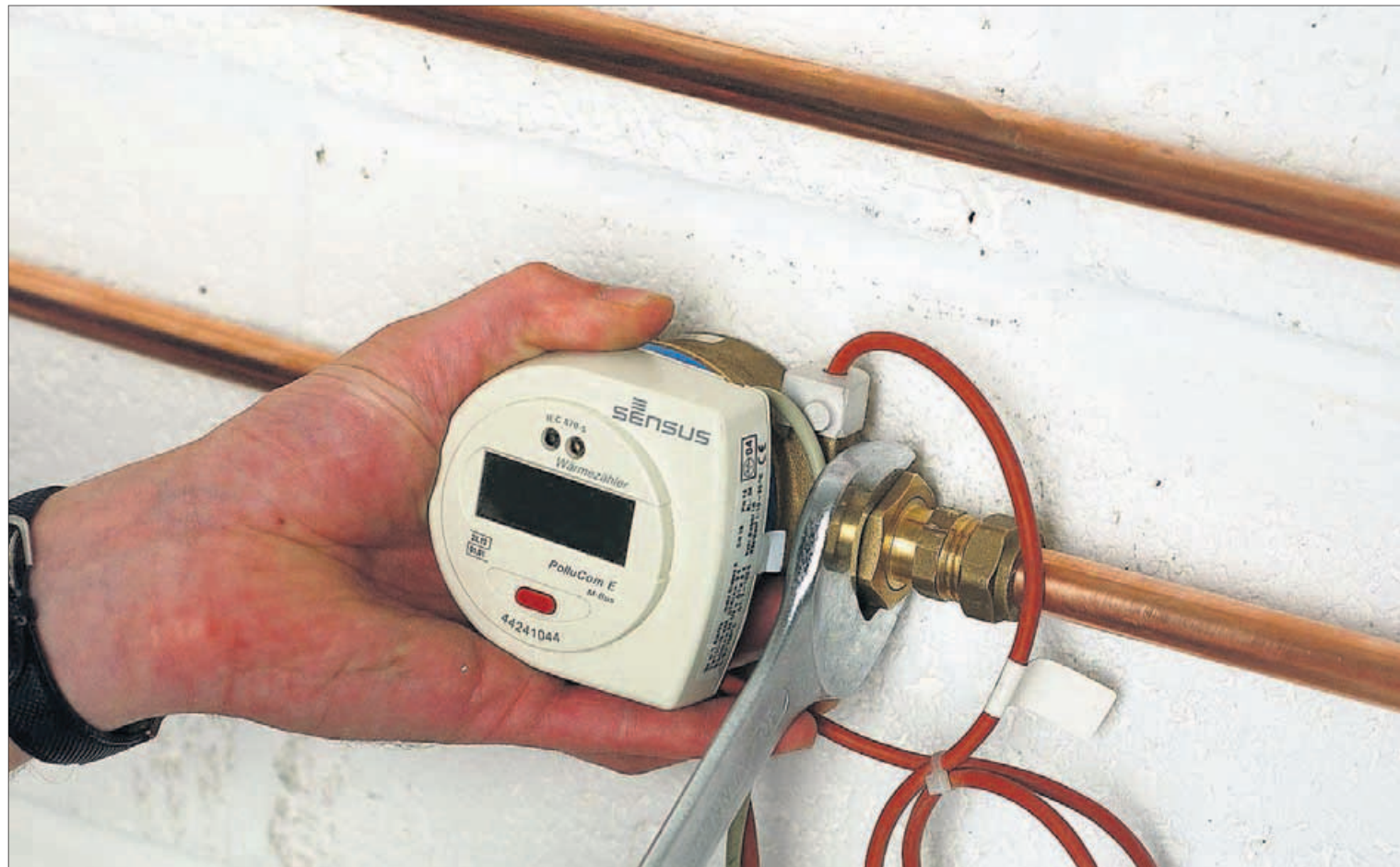
Comtador de energía inyectada a la calefacción.
